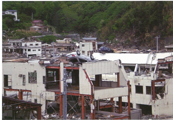
ビルの屋上に乗用車が。津波がこより高きことが分かる(宮城県女川町)
